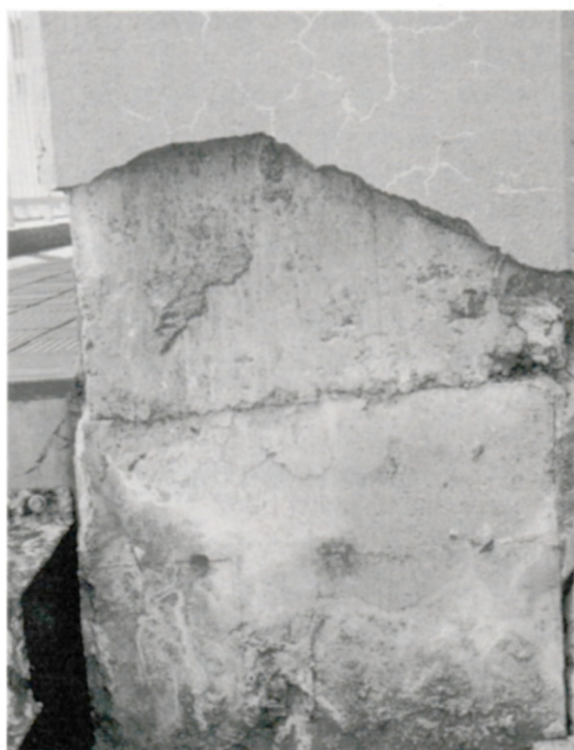
写真4-4 マンション基部の鉄骨の剪断破壊
