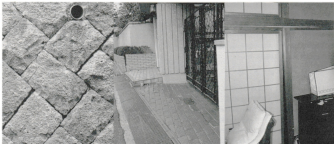
写真2-1 開いた石積みに見られる打撃痕と貝がら状の欠け
