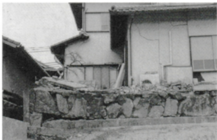
写真3 『突き固め』によって短縮した盛土地盤と全壊した家屋
